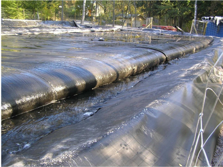
Joonis 1. Settega täidetud geokonteinerid Gallträki järve kaldal (Foto: Mati Tõnismäe, http://pk.emu.ee/userfiles/Tervendamine/Ptk.10.pdf )
