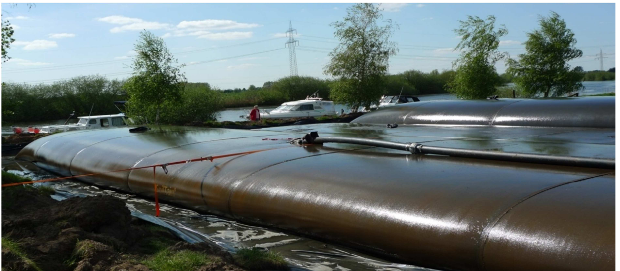
Joonis 2. Settega täidetud geokonteinerid (Huesker & J.F. Knauer, 2011)
