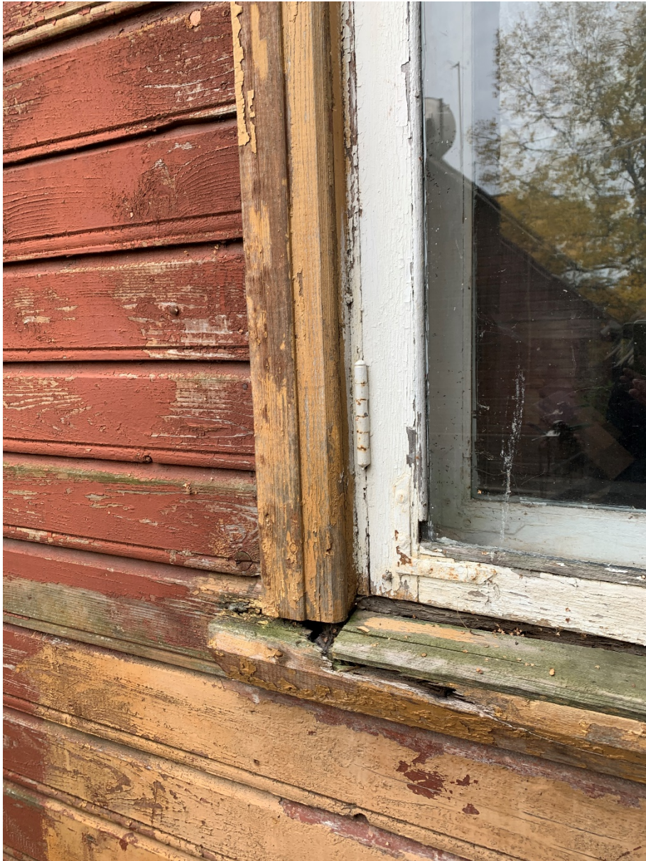
Foto 1. Väljast akna alumine laudis välja vahetada
