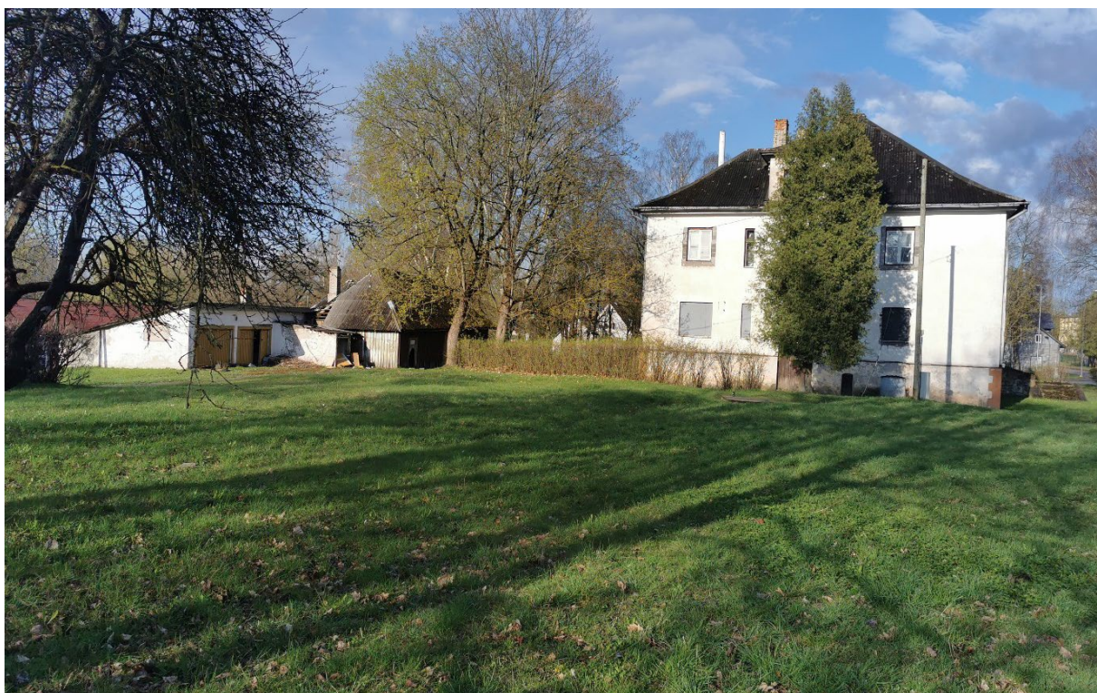
Joonis 6. Kungla tn 37 kinnistu peahoone ning kõrvalhooned
