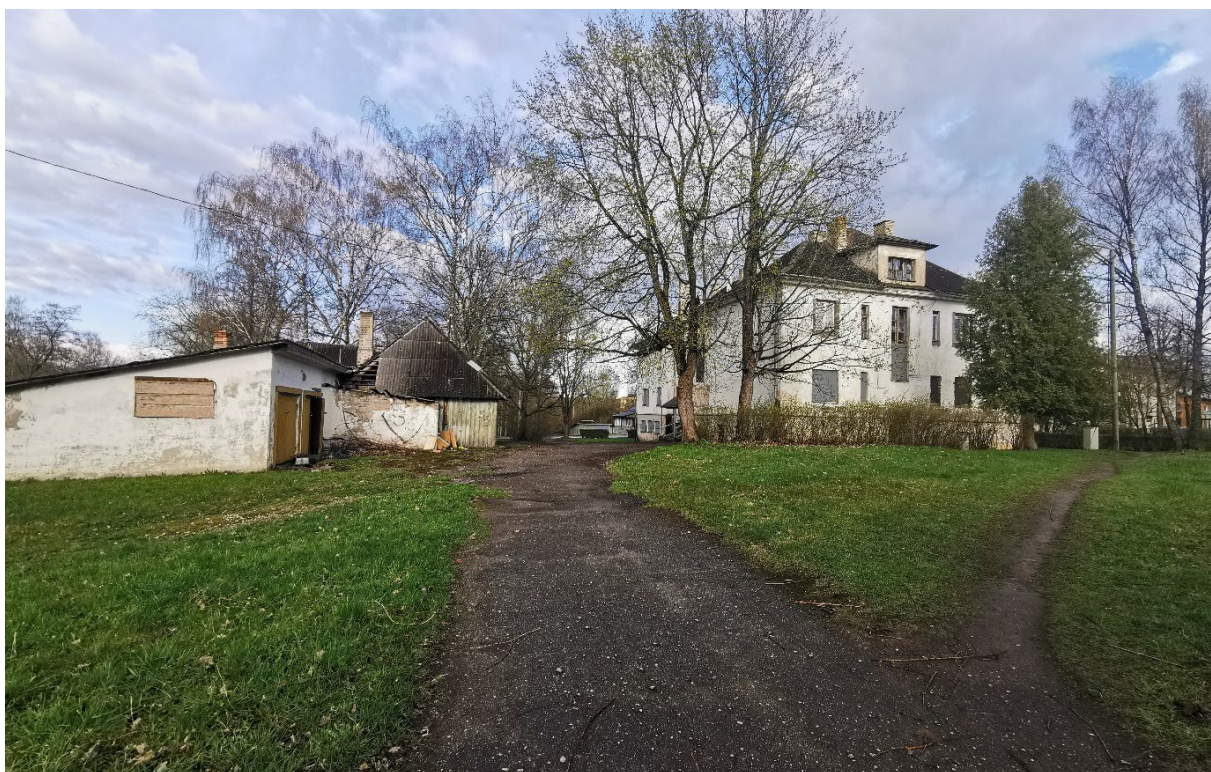
Joonis 4. Kungla tn 37 kinnistul asuvad hooned, mida soovitakse võimaluse korral lammutada
